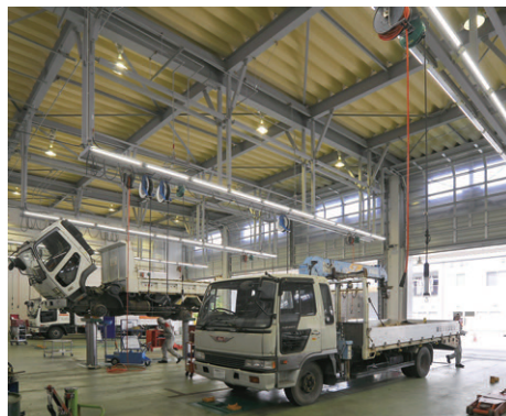
精密作業を満足した明るさで省エネを両立したLEDラインタイプの照明(大型車整備工場)
