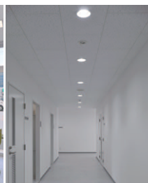
LEDダウンライト+人感センサーによる廊下の照明
