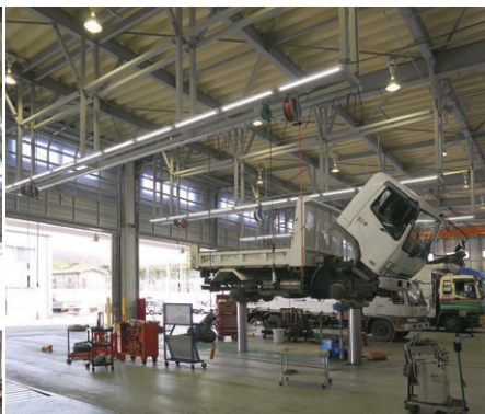
整備車のサイドを効率よく、明るく照射するLEDラインタイプによる照明(一般車整備工場)
