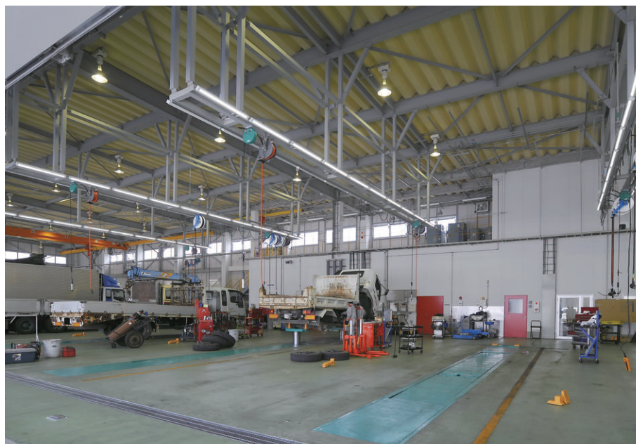
サービス整備工場の照明 ベース照明のNF400W高天井用反射笠器具のほか、作業灯としてLEDベースライトスリムストレートタイプを吊り工具棚に配置
