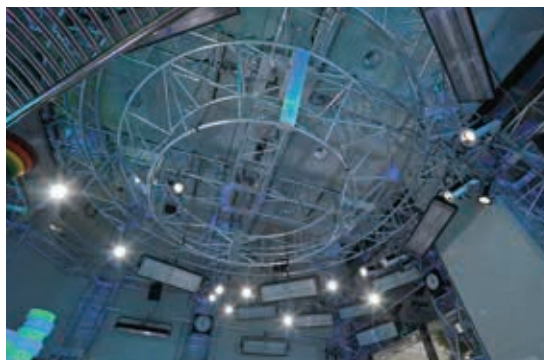
天井から吊られた円型トラスにLEDスポットライトを配置
