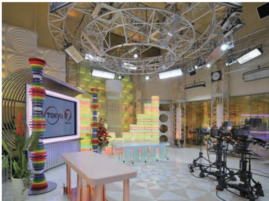
テレビ東京本社に設けられた多目的スペース「7スタ」 重点照明にはLEDスポットライト6000クラスを採用
