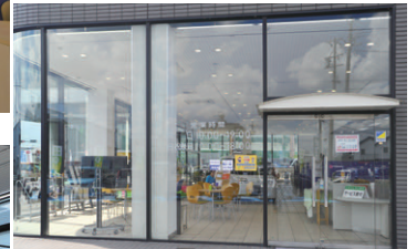
ガラス張りカーテンウォールから内部を望む
