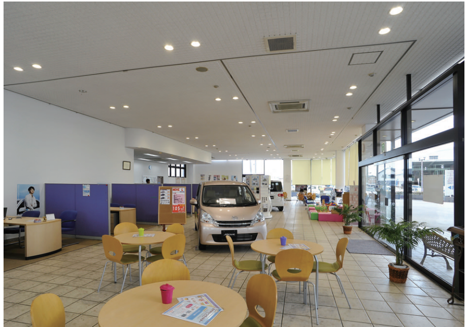
HIDダウンライトからLEDダウンライトに更新したカーショールーム 既存と同等以上の明るさを確保しながら大幅な省エネ・CO 2 排出量を削減
