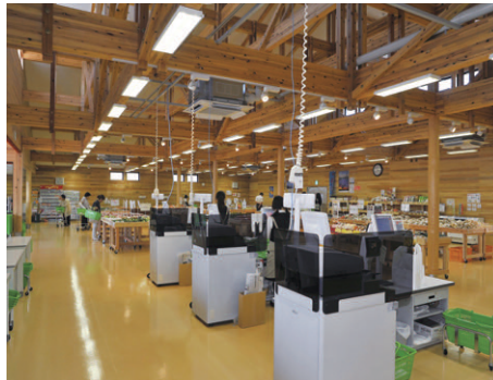
LEDベースライトストレートタイプ直付形によるレジ周りの照明
