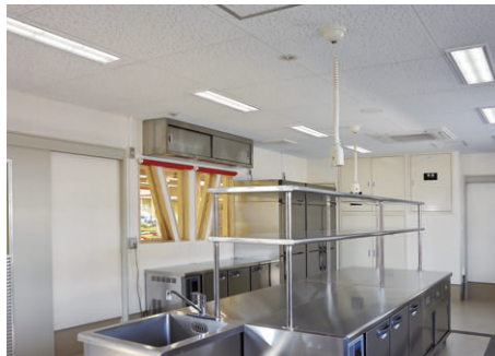
惣菜加工室にはLEDベースライトストレートタイプ埋込形を採用
