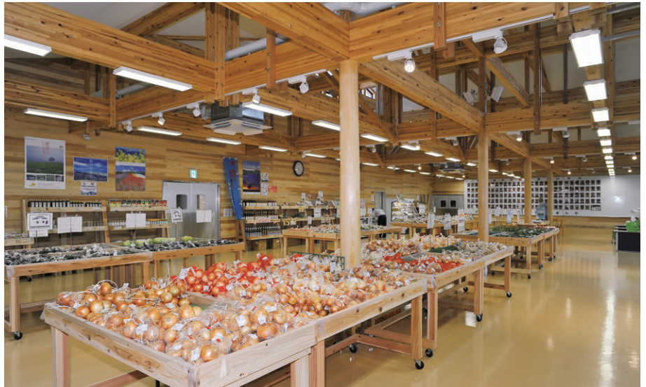
農産物売場のLED照明 ベースにLEDベースライトストレートタイプを、重点照明にLEDスポットライトライティングレール用を採用。省エネしながら商品を効果的に照射
