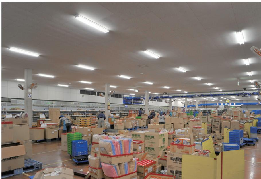
入・出荷エリア方向から奥の原料補給エリア・集品室の照明を望む 直管形LEDベースライト直付形逆富士器具を設置
