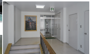
階段踊場のLED照明
