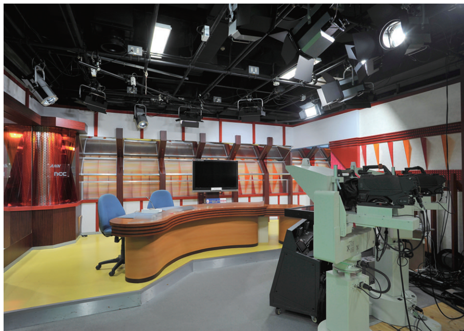
ニューススタジオ時のスタジオ全景 スタジオ照明がフルLED化され、大幅な消費電力を削減しながら商品撮影時の色味の再現性もよく、良質なスタジオ照明環境を發揮。
