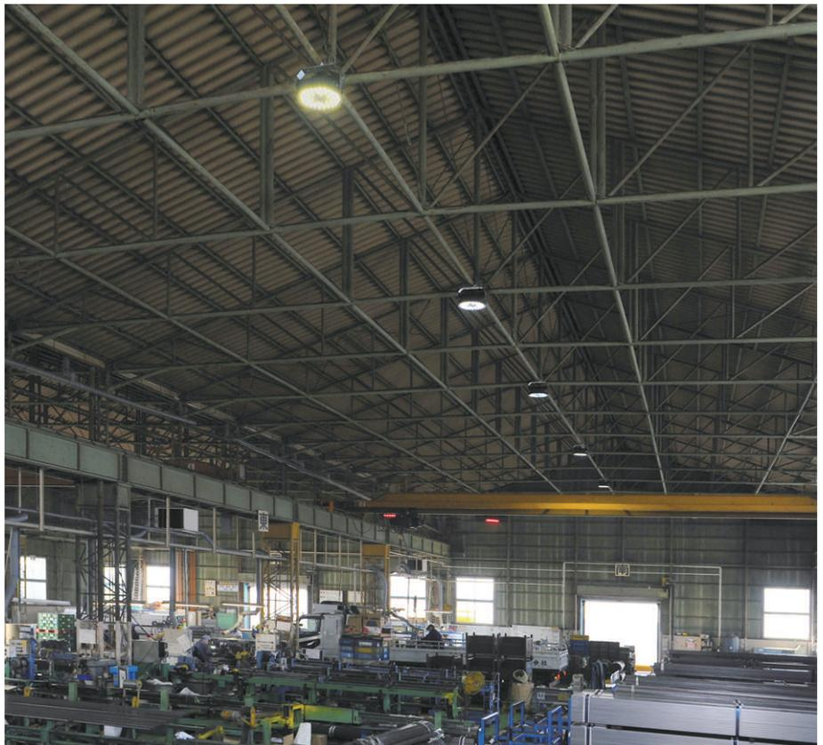
A・B棟のLED照明 400W水銀灯高天井用反射笠器具から200WLED高天井器具に更新し、大幅な省エネ・CO<sub>2</sub>排出量を削減
