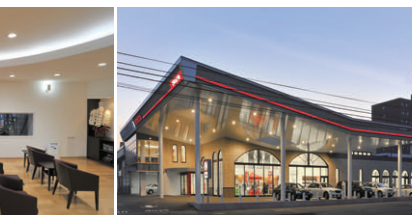
LED光がガラスから漏れて存在感を演出する夜の外観
