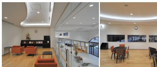
レディースコーナーの照明 LEDによる間接照明とお客様スペース接照明とベース照明のLEDダウンライト
