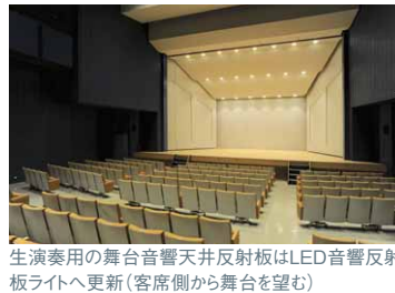
生演奏用の舞台音響天井反射板はLED音響反射板ライトへ更新（客席側から舞台を望む）
