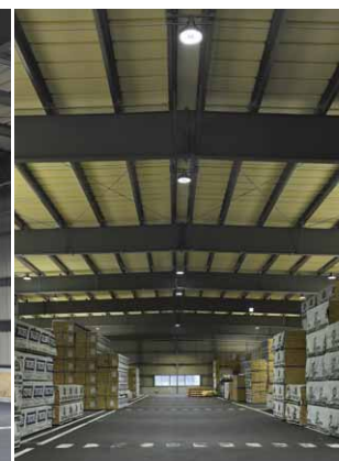
庫内通路部のLED高天井器具
