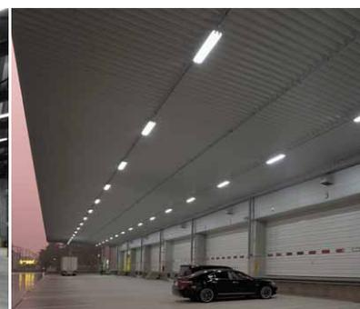
1階バース部の軒下には直管形LEDベースライト笠付防湿・防雨形器具を採用
