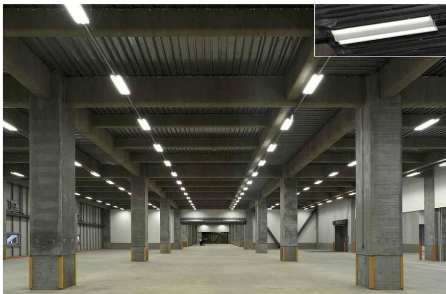
2階倉庫スペースの照明 5mを超える天井に設けたレースウェイに一体形LEDベースライト薄形タイプを整列配置
