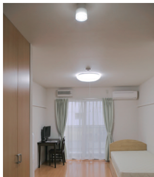
寮室の照明 入口付近にLED直付ダウンライト、ベース照明には蛍光灯サークルライン
