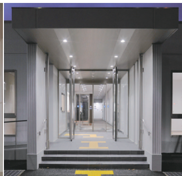
玄関・軒下の照明 メンテナンスの手間が省けるE-CORE60軒下用を採用
