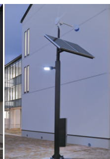
太陽光発電・風力発電システムによるLED外路灯
