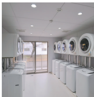
洗濯室の照明 E-CORE60+人感センサで自動ON・OFF制御
