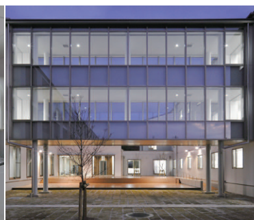
渡り廊下外観夜景 白色相当のE-COREでさわやかな照明を形成
