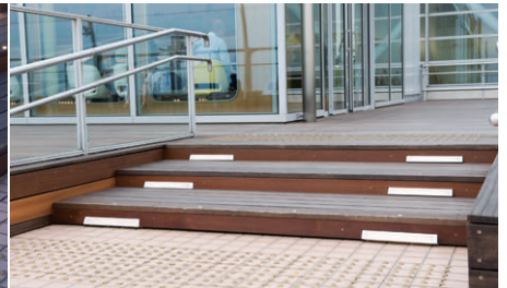
夜間の階段面 LEDモジュール3連結で1ユニットの特注仕様 手摺階段側 ポリカーボネートカバーを装着する
