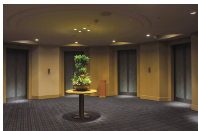
エレベータホールのLEDユニバーサルダウンライトによる照明
