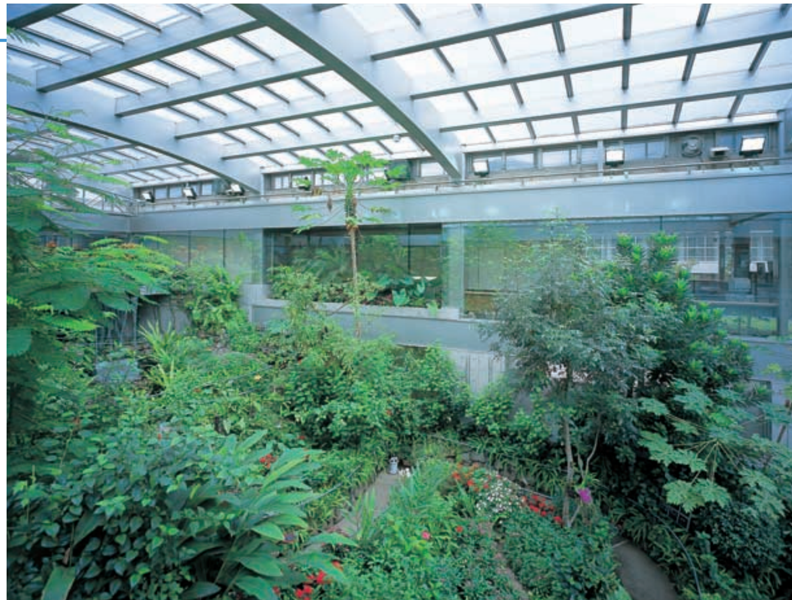
放蝶温室 The Butterfly Greenhouse アトリウムによる自然光の利用を行っているため、夜間時の補助照明として高所にメタルハライドランプ投光器を設置
