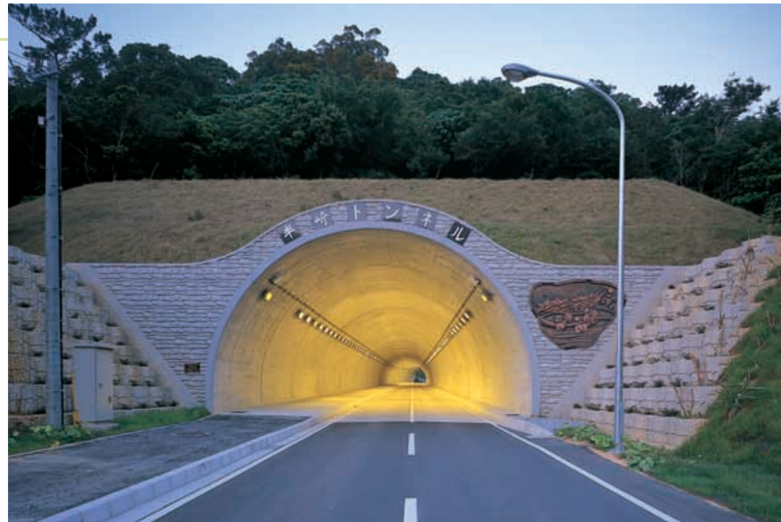
光触媒膜応用トンネル照明器具が採用された半崎トンネル Lighting apparatus using lamps coated with photo catalyst films is employed for Hanzaki tunnel 光源は基本照明には低圧ナトリウムランプを、入口照明には高圧ナトリウムランプを使用
