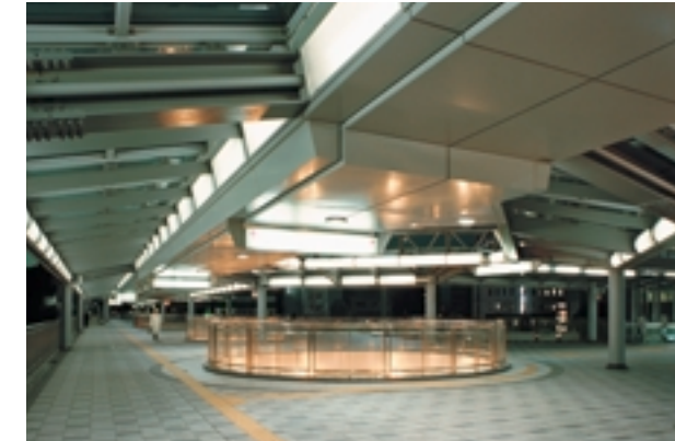
北口ペDESTリアンデッキ上 View from above the pedestrian deck at north exit バンチングメタル内の蛍光灯器具で十分な鉛直面照度を得ている
