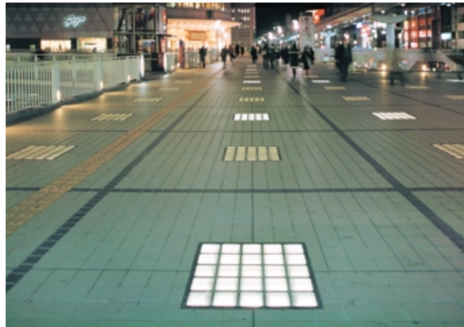
南口ペDESTリアンデッキ上 ガラスブロックを通して浮び上る光の明るさにも変化をつけリズムミカルな雰囲気となっている View from above the pedestrian deck at south exit
