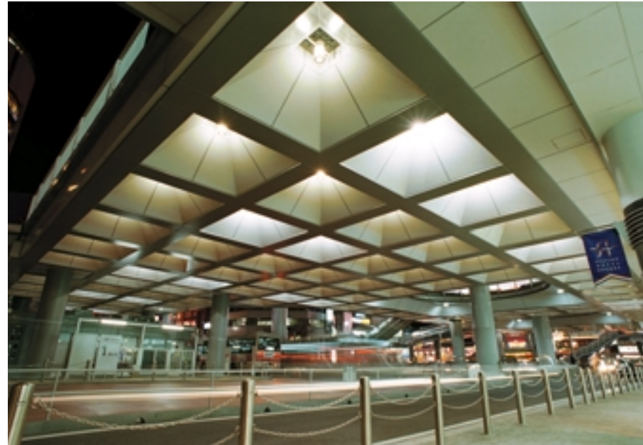
南口ペDESTリアンデッキ下 デッキ自体の圧迫感を感じさせないよう天井全体を明るくしている Under the pedestrian deck at south exit
