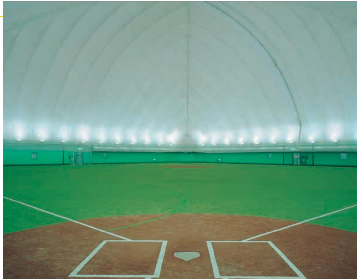
アリーナ内部 コンクリート軒に設置された投光器より空気膜屋根に照射してその反射光でアリーナ全体に明るさを確保
