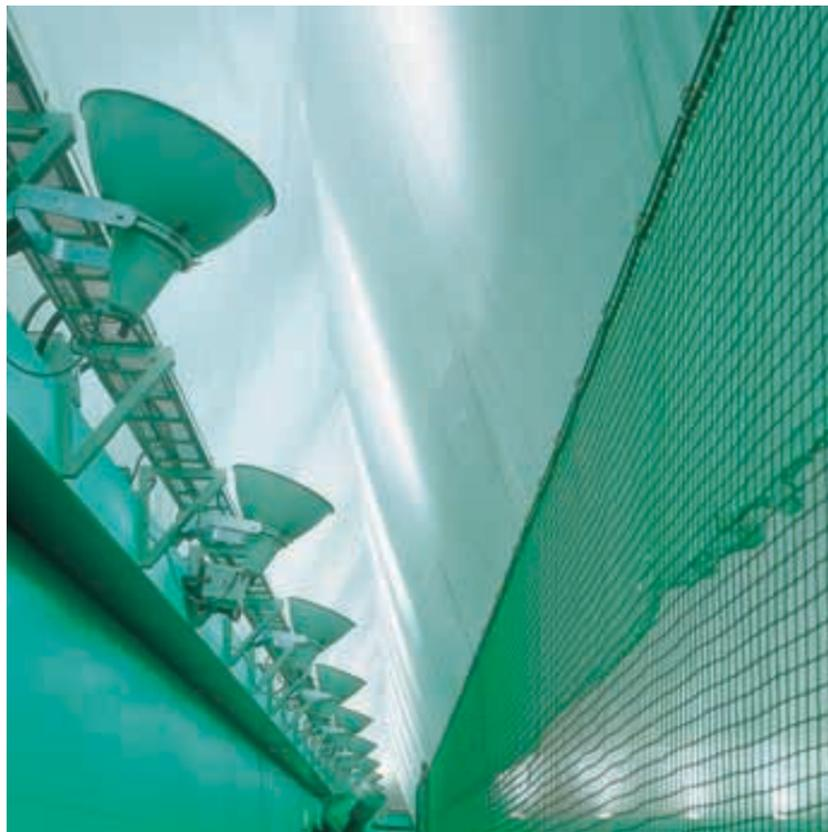
照明器具設置状況 コンクリート軒に設置されたHID投光器
