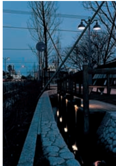
木製テラス・水路 Wooden terrace
