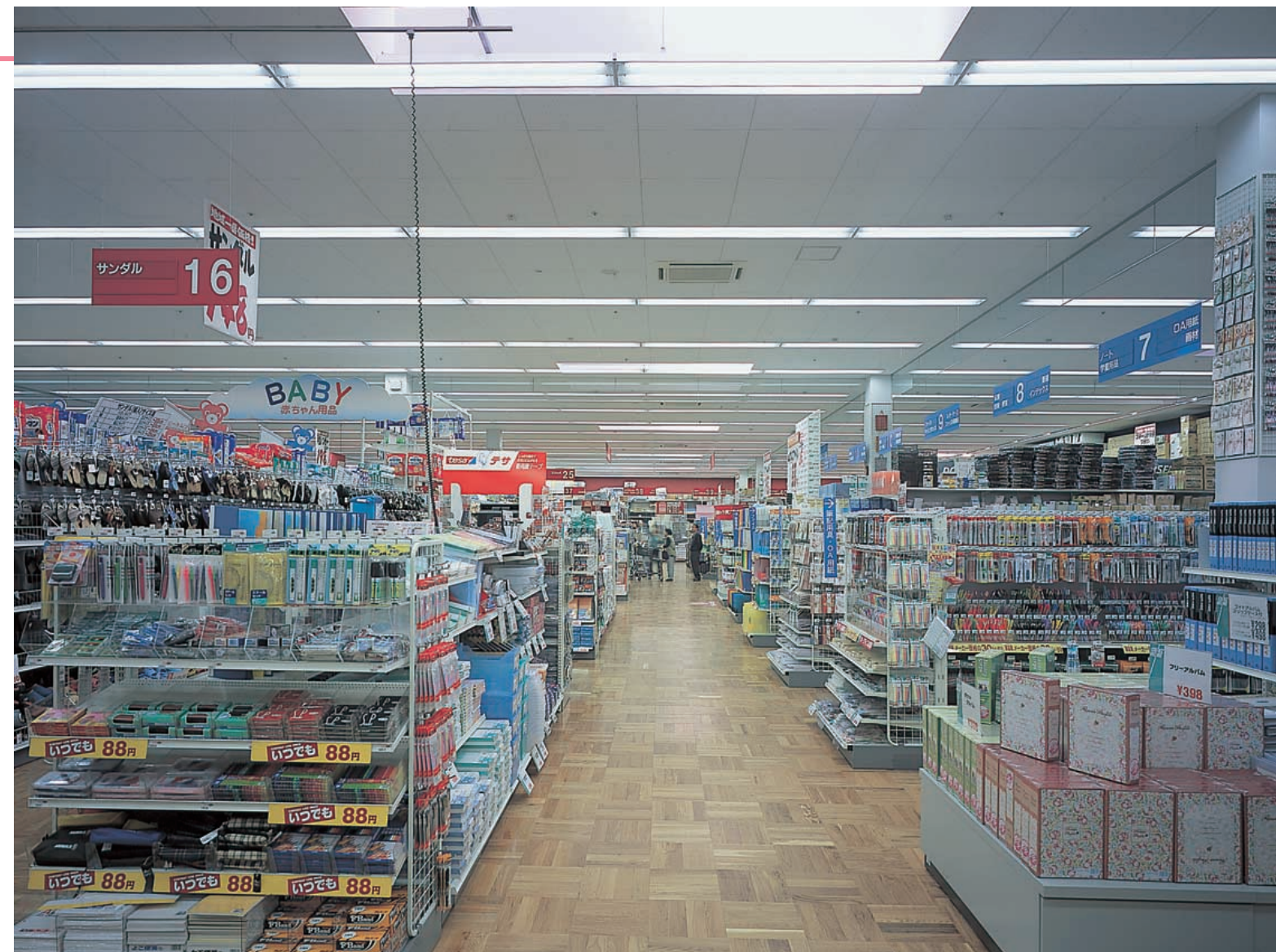
インテリア・住関連商品売場 FL110W埋込器具を採用。活気に満ちた明るい光環境をつくり出している Floor for interior and housing-related goods
