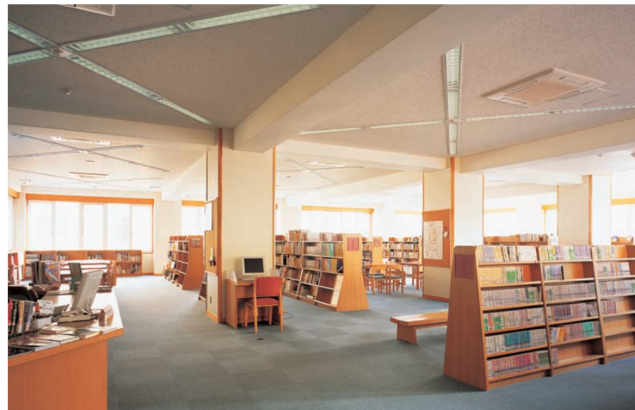
図書室 Hf32W埋込器具(ルーパ付)をX形に配置。MESL-Sと照度センサにより昼光利用制御を行っている Library
