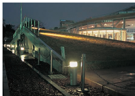
広場通りのアプローチ照明 Approach lighting along passageway to the square
