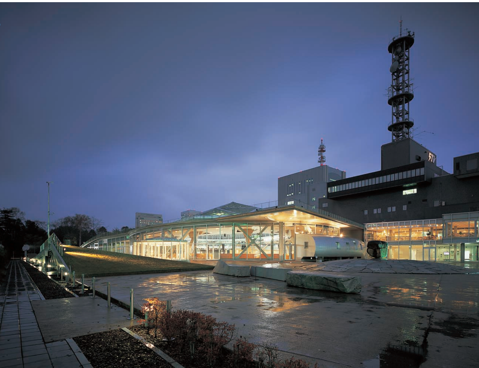
ガラスのカーテンウォールに囲まれた屋内空間の照明と、ガラスの開閉屋根から漏れる光による美しく感動的な夜景をつくり出している Interior lighting surrounded by glass curtain wall as well as the light seen through an open/shut glass roof produce the impressive night view
