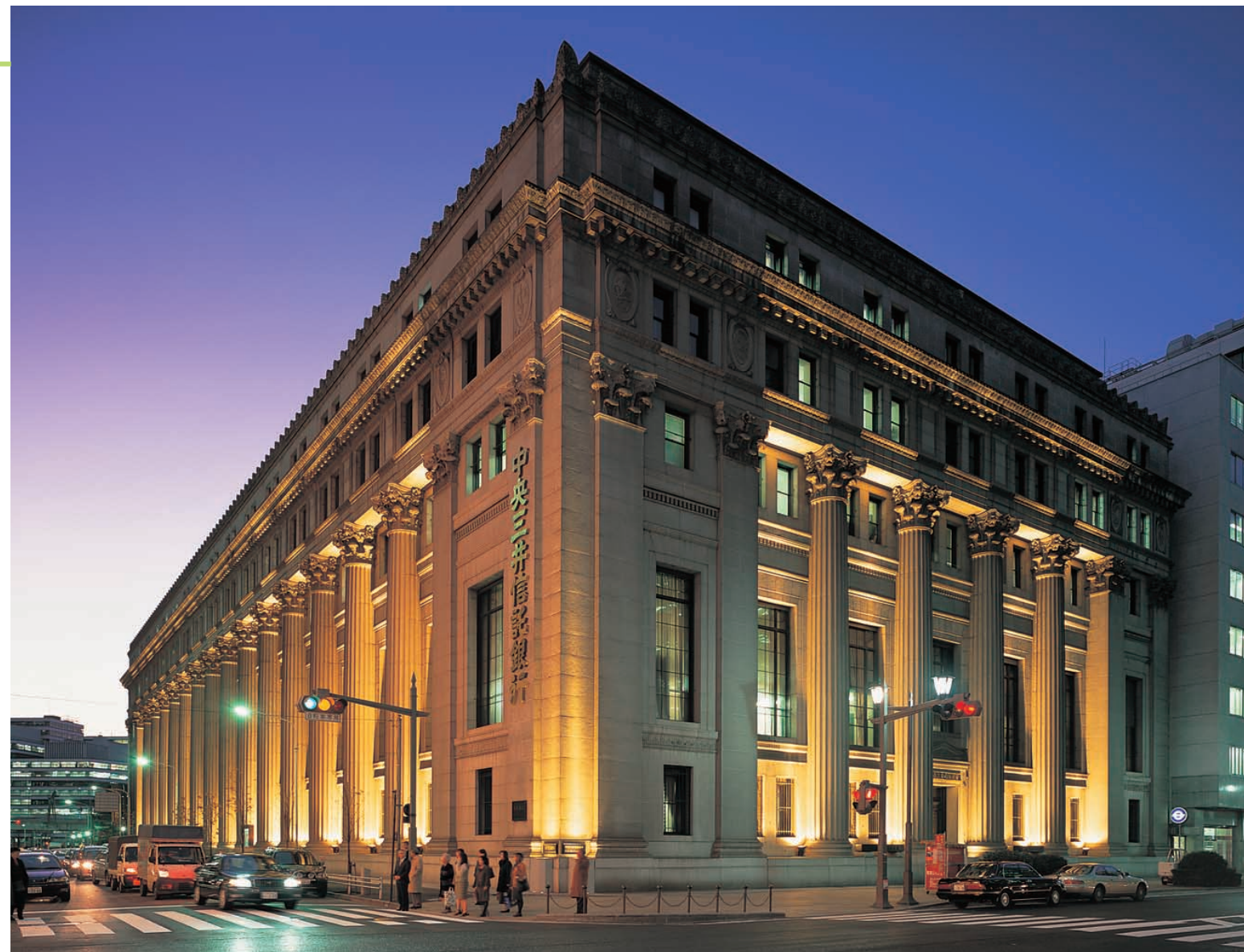
中央通りから望む薄暮の景観：300Wメタルハライドランプと270W高圧ナトリウムランプの投光器を使用し、季節に適した照明演出を行っている Building at dusk viewed from the Chuo-dori
