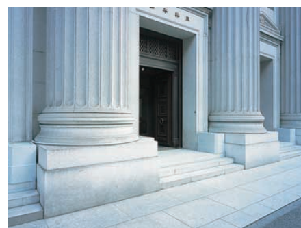
玄関周辺に設置した投光器ボックス Boxes of floodlights installed on the front entrance
