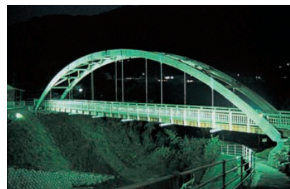
木製人道橋の夜景：400Wメタルハライドランプ投光器(フード付ルーバ)によりライトアップ。通路部は上方光束比0%の器具(100W HIDブラケット)を配置 Night view of wooden pedestrian bridge
