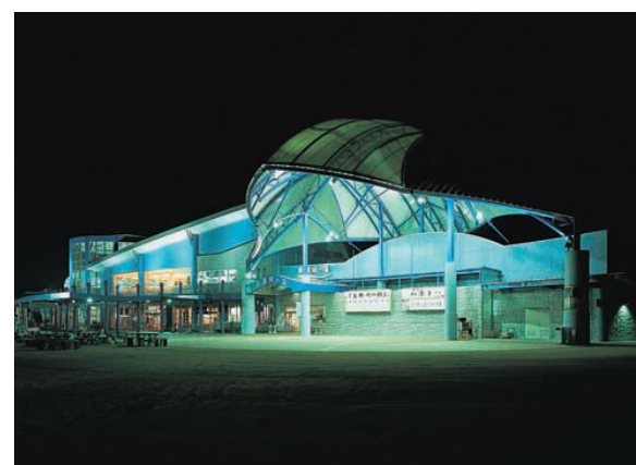
イベント広場：250Wメタルハライドランプ投光器をドーム内部より天井幕とドーム空間に照射。ドーム天井から透過した柔らかな光が幻想的な雰囲気をつくり出している Event square
