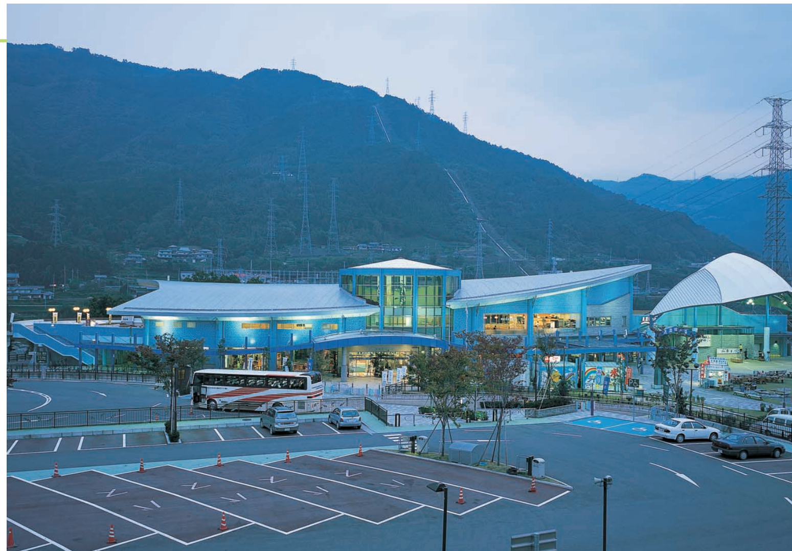
ふれあい館のライトアップ：壁面や長く突き出した庇を250Wメタルハライドランプ投光器具でライトアップ。天空や周辺への光漏れを抑えながらシンボリックな外観を効果的に映し出している Light-up of Fureai-kan hall
