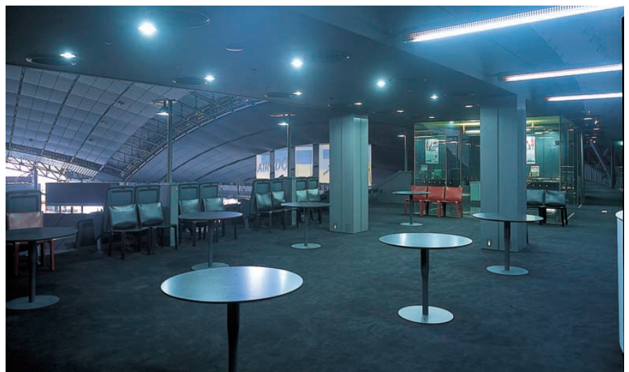
4階客席にあるスイートシート：通路部には110W蛍光ランプパンチング加工の化粧カバー付を設置。下がり天井面にはFHT32W2灯用ダウンライトを設け、客席への明かりもれを防止しながら落ち着いた雰囲気をつくり出している
