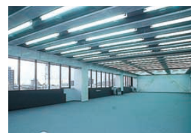
メディアセンター：スタッフの休憩室として使用。110W蛍光ランプパンチング加工した特注器具でコンクリート色に合わせて塗装している
