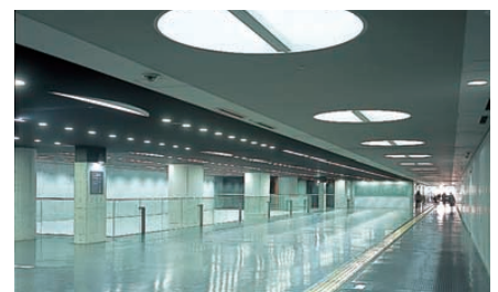
1階ストリート：円形状にくり貫いた天井意匠内には上方照射とした110W蛍光ランプを設置。留り場には建築化照明で安らぎ感のある光環境を演出
