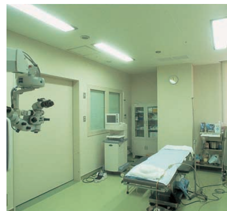
処置室の照明：清浄度を高めるため高出力形の2灯用クリーンルーム用器具を採用
