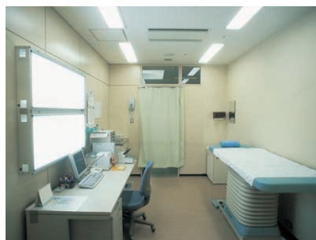
診察室の照明：32W Hf蛍光ランプ2灯用埋込器具を設置
