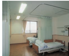
埋込スクエア器具を整列配置したデイケアの照明
