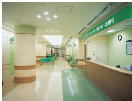
各科外待合室の照明：窓口前にはダウンライトを、待合室には間接照明とウォールウォッシャ照明器具を採用
