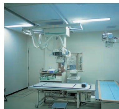
処置室の照明：清浄度を高めるため高出力形の2灯用クリーンルーム用器具を採用
