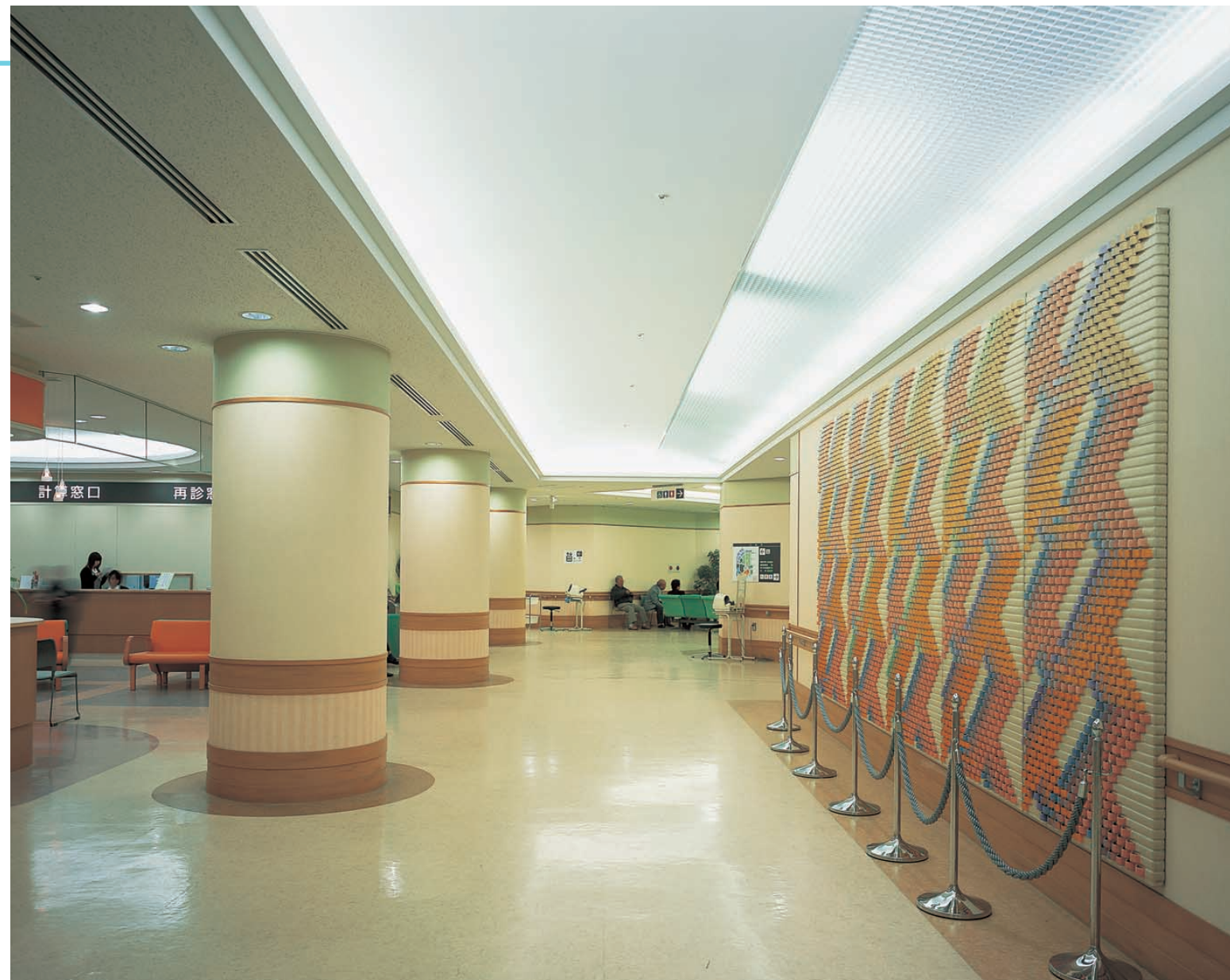
ホスピタルストリートの照明：外光をふんだんに採り入れた折り上げ天井は32W Hf蛍光ランプ笠なし器具を採用した間接照明としている
