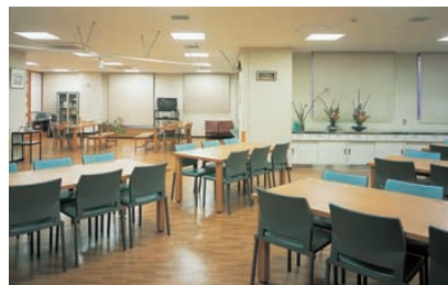
埋込スクエア器具を整列配置したデイケアの照明
