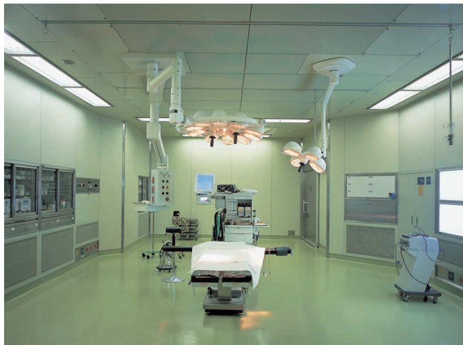
手術室の照明：前面強化ガラス付の32W Hf蛍光ランプ4灯用特注クリーンルーム用器具を連結設置で口の字形に配置。全点灯、1/2点灯を可能とし、作業効率を高める照明環境を実現
