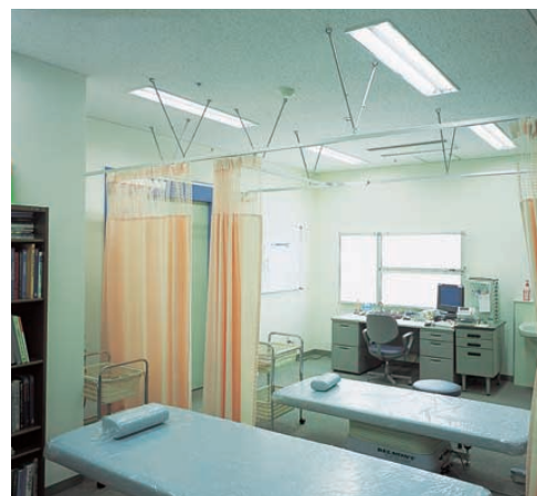
診察室：患者が上向きになった時の眩しさを抑制するため、調光可能な32W Hf蛍光ランプ2灯用埋込器具を採用し、スクリーンで仕切られた場合の照度分布にも配慮している
