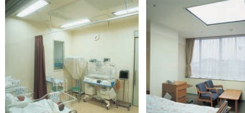
新生児室の照明：32W Hf蛍光ランプ2灯用クリーンルーム用器具を設置
