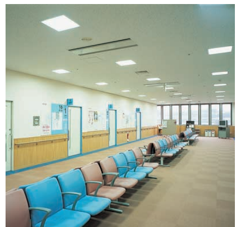
外来待合室の照明：36Wコンパクト形蛍光ランプ3灯用カバー付スクエア器具を並列配置し、待ち時間を快適に過ごせるよう明るく空間を形成
