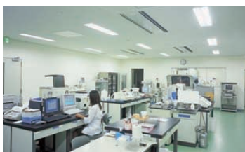
中央検査室：32W Hf蛍光ランプ2灯用埋込器具を並列配置し、明るく清潔な視環境をつくり出している
