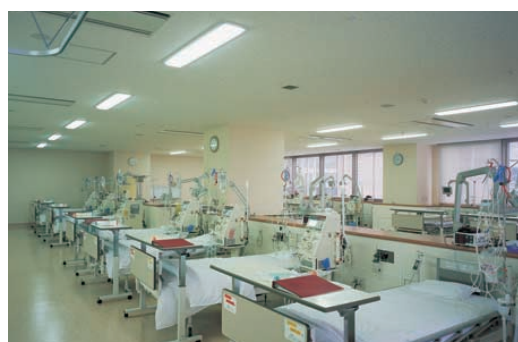
透析室：最新設備を備えた30床の広い透析室。32W Hf蛍光ランプペン皿付埋込器具を配置し、天井面も明るくし、鉛直面照度も高めている
