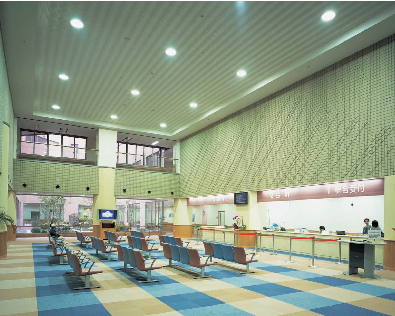
総合待合室：2層吹抜けの開放的な空間で、400Wメタルハライドランプ電動昇降装置付ダウンライトを配置。明るいなかにも安心感、清潔感が高められており、かつ、メンテを容易にしている
