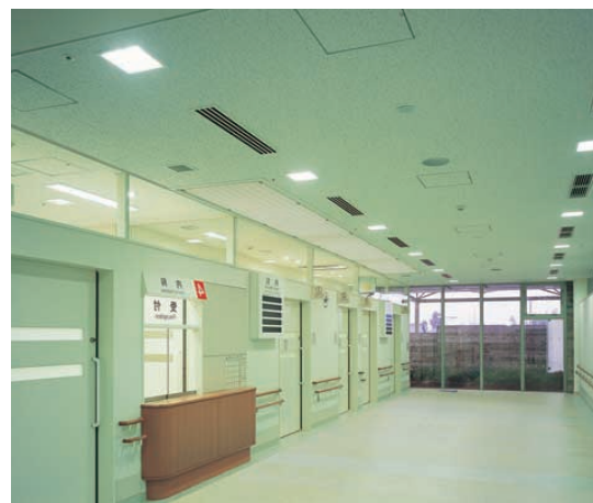
各科の外待合室の照明：36Wコンパクト形蛍光ランプ2灯用スクエア器具を設置
