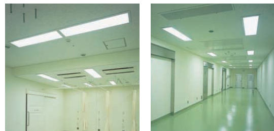
救急室の照明：32W Hf蛍光ランプ2灯用及び1灯用クリーンルーム用埋込器具(カバー付)を設置
