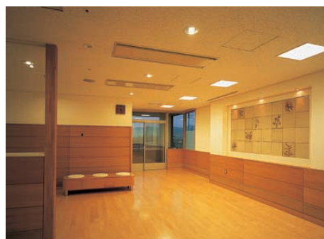
食堂・談話室の照明：36Wコンパクト形蛍光ランプ3灯用埋込スクエア器具と27Wコンパクト形蛍光ランプダウンライトの組み合わせ配置
