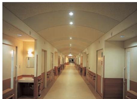
コンパートメントをイメージした廊下の照明：32Wコンパクト形蛍光ランプダウンライトを配置
