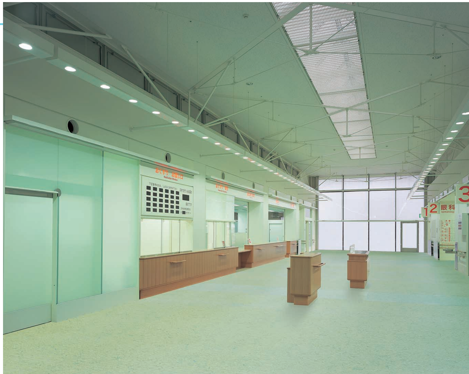
ホスピタルモールの照明：高天井に吊り下げられた32Wコンパクト形蛍光ランプ特注ダウンライトを組み込んだ照明ユニットボックスを連続配置している
