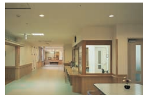
住居ゾーン廊下の照明：27Wコンパクト形蛍光ランプダウンライトを採用
