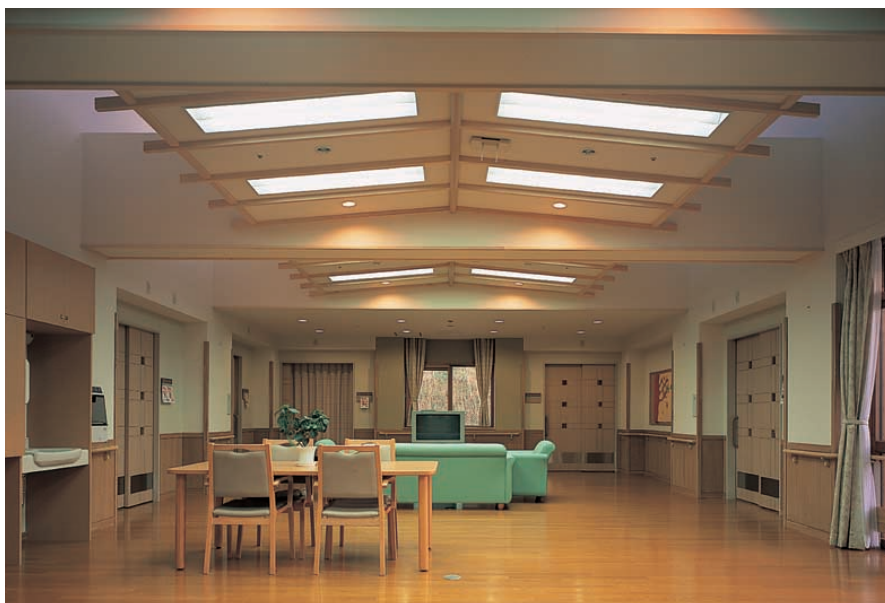
グループケアユニット談話室の照明：ハイサイドライトで採光と通風を採り入れ、照明は32W Hf蛍光ランプルーバ付埋込器具と調光のできる60W白熱電球ダウンライトを組合わせて小規模なイベントに対応することができるように配慮
