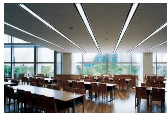
食堂：32WHf蛍光灯ランプ埋込器具をライン配置
