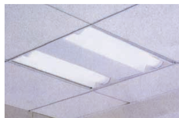
グリッド照明システム：乳白アクリルセードで光源のまぶしさを抑え、ほどよい拡散光が得られている。中央部には空調ディフューザ等の他設備を配している
