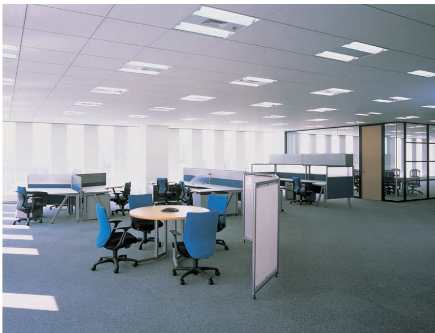
事務室の照明：グリッド照明システムを採用し、等間隔で規則配置されている
