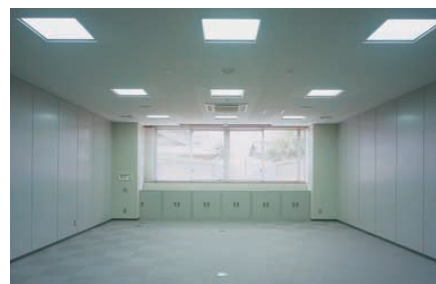
会議室の照明：55Wのコンパクト形蛍光灯3灯用埋込深枠スクエア器具(カバー付)を整列配置
