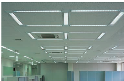
執務室の天井面：日の字配置で、机のレイアウト変更の場合でも照明が支障にならない快適な執務環境を可能にしている
