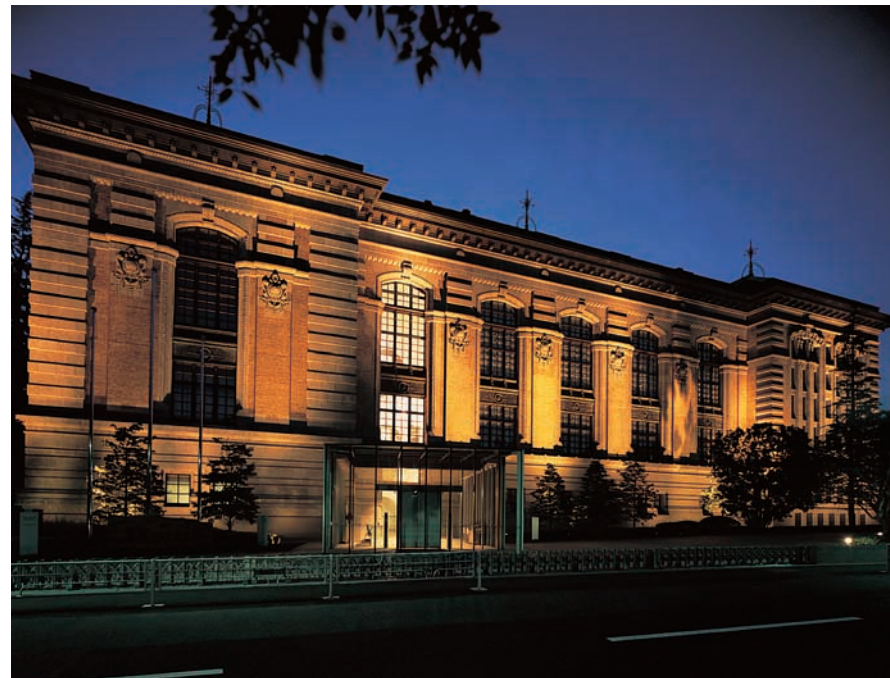
高演色形ナトリウムランプを採用し、壁面上部には狭角形投光器で、壁面下部には地中埋込形投光器でライトアップ
