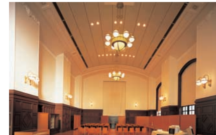
3階「ホール」の照明：60W一般電球8灯用シャンデリア(復元)3基を設置
