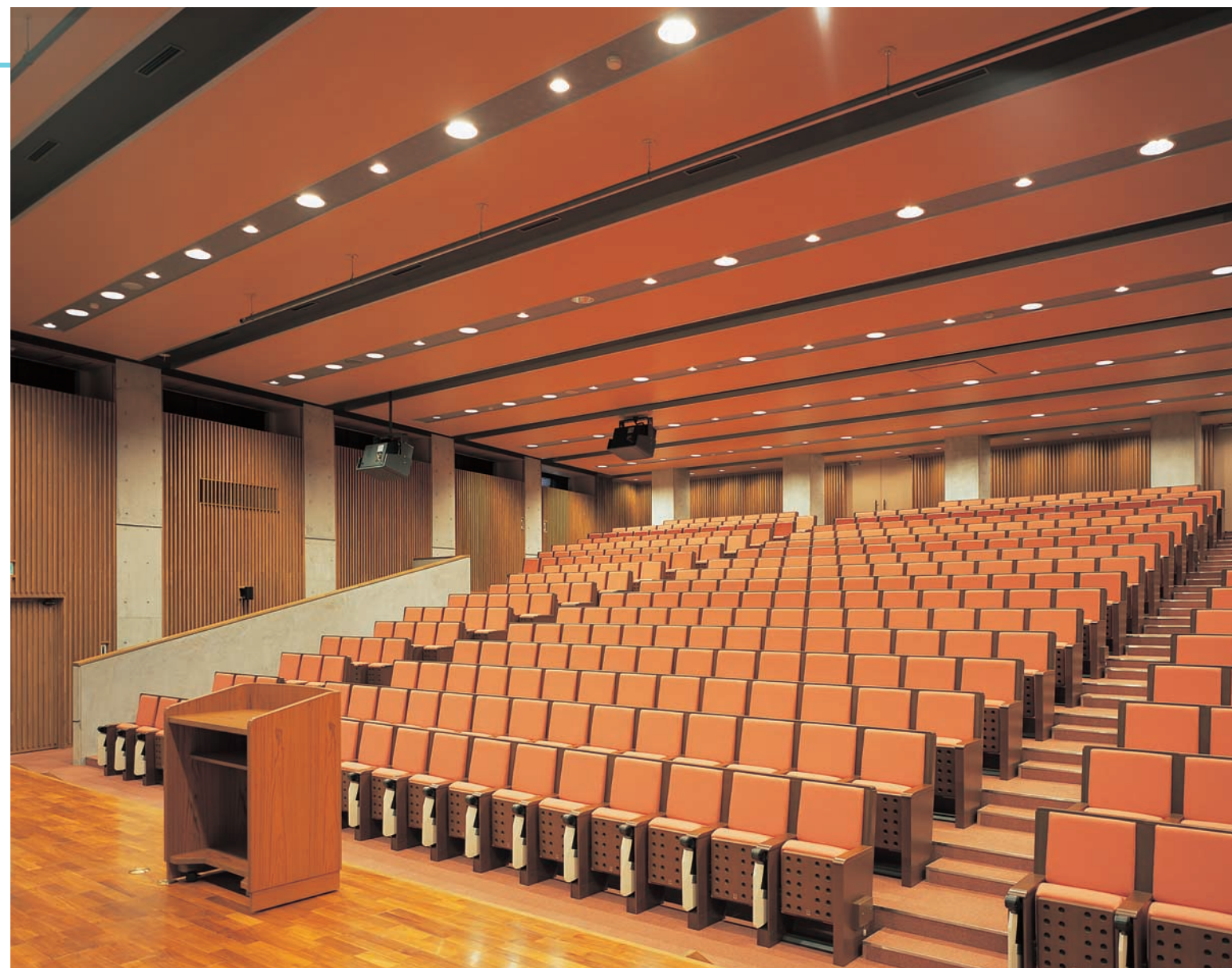
特大教室の照明：天井スリット内に32Wコンパクト形蛍光ランプ3灯用ダウンライト(調光形)と27Wコンパクト形蛍光ランプダウンライトを交互に配置。5～100%の調光を可能にしている
