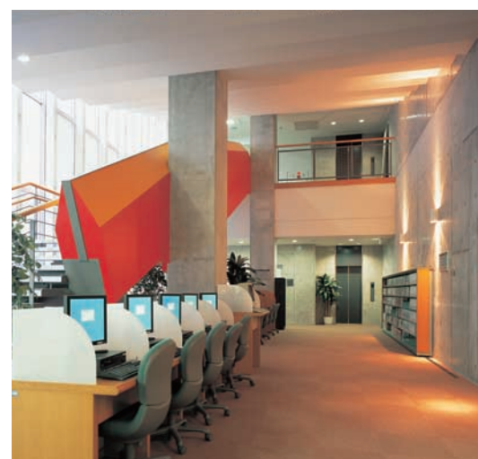
図書館AVコーナーの照明：階段式天井にコンパクト形蛍光ランプダウンライトを、壁面には特注ブラケットを配置
