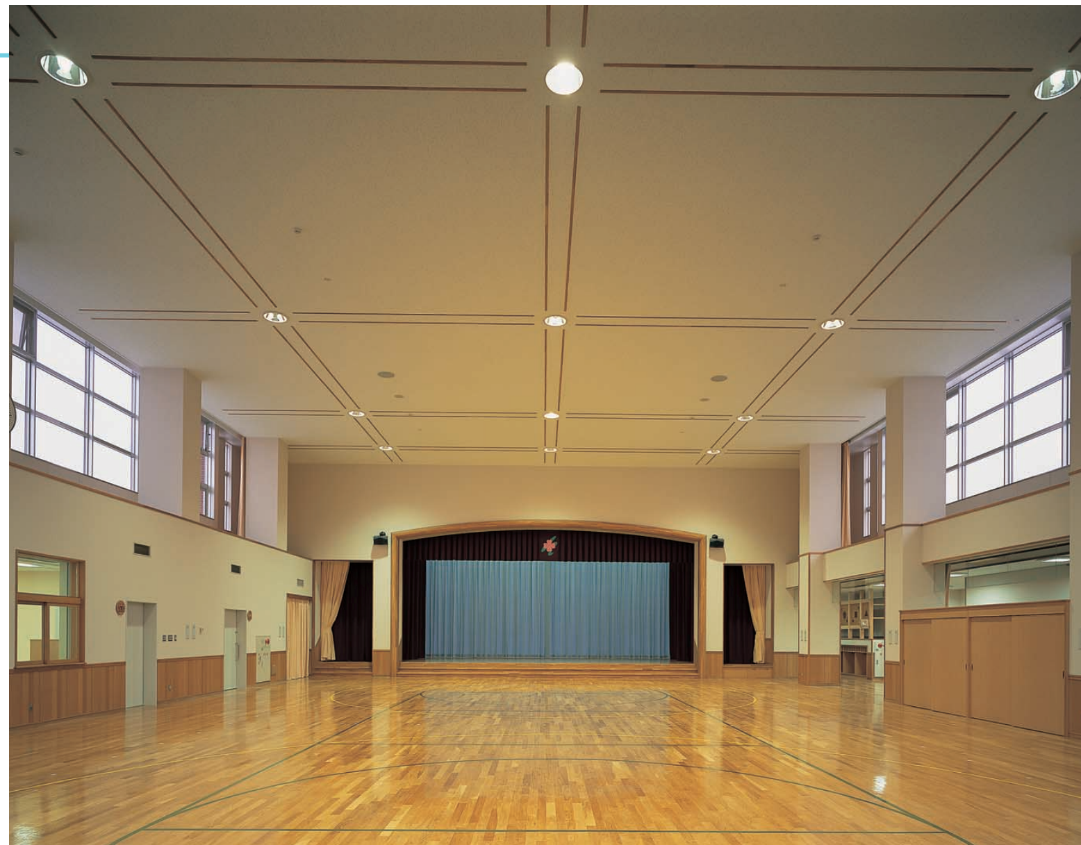
プレイルームの照明：メタルハライドランプ(EB形)高天井用埋込器具を採用。インバータ化された安定器を採用することにより、ランプのチラツキによるもの見え方の違和感をなくしている
