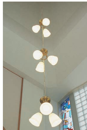
おはなしコーナーの電球形蛍光ランプ9灯のシャンデリアチェーン吊り
