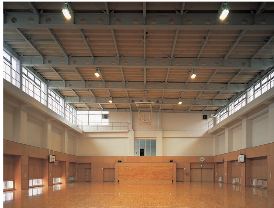
体育館の照明：混光照明器具(400Wメタルハライドランプ・360W高圧ナトリウムランプ)を採用し、暖かな雰囲気のあるスポーツ空間を形成
