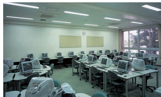
パソコン教室の照明：CRT画面への映り込み防止を図るためパッフル付の32WHf蛍光ランプ2灯用埋込器具を採用
