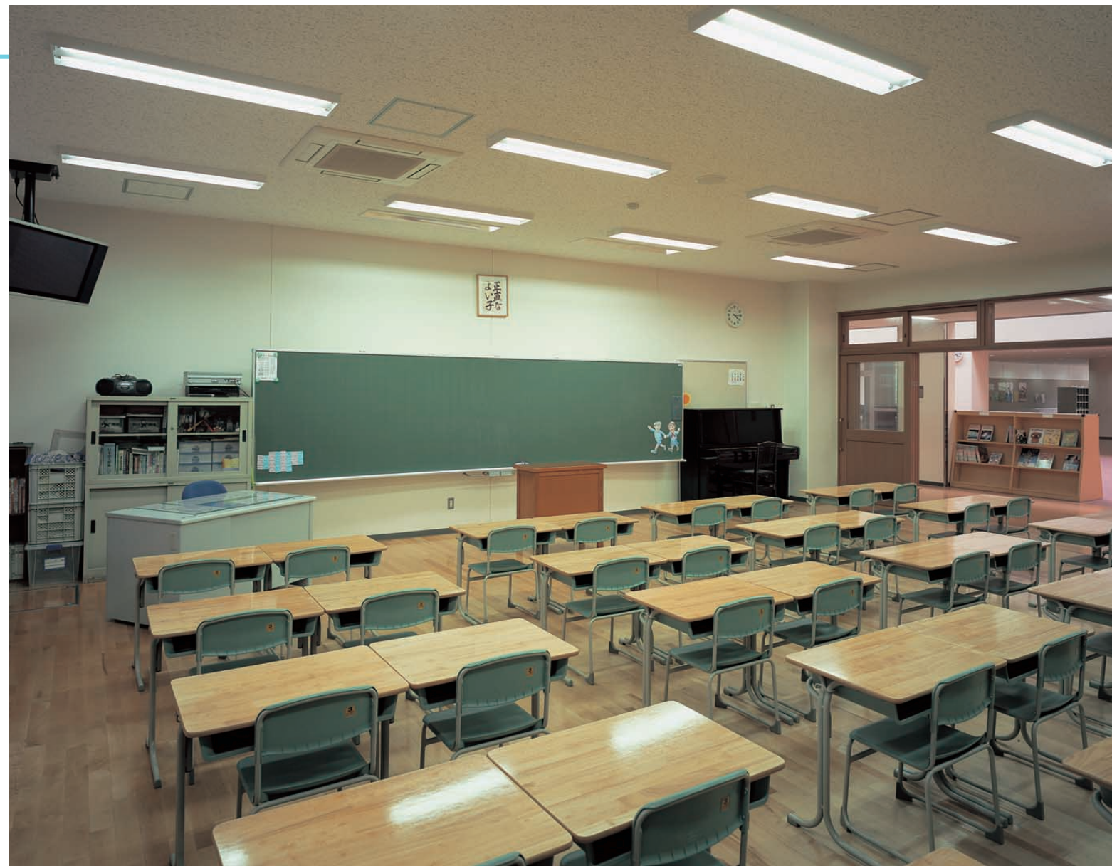
一般教室の照明：32WHf蛍光ランプ2灯用直付遮光角制御器具を採用し、窓際の照明器具にあかりセンサを使用して調光を行っている
