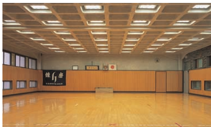
剣道場の照明：32Wコンパクト形蛍光灯3灯用薄形埋込器具をます状天井内に設置
