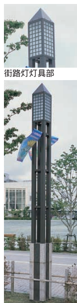
歩道用街路灯(照明ポールH=4.6m)
