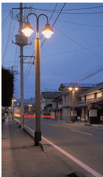
灯具に2灯用ニューストリートライトを採用し、天空への光漏れを防止している
