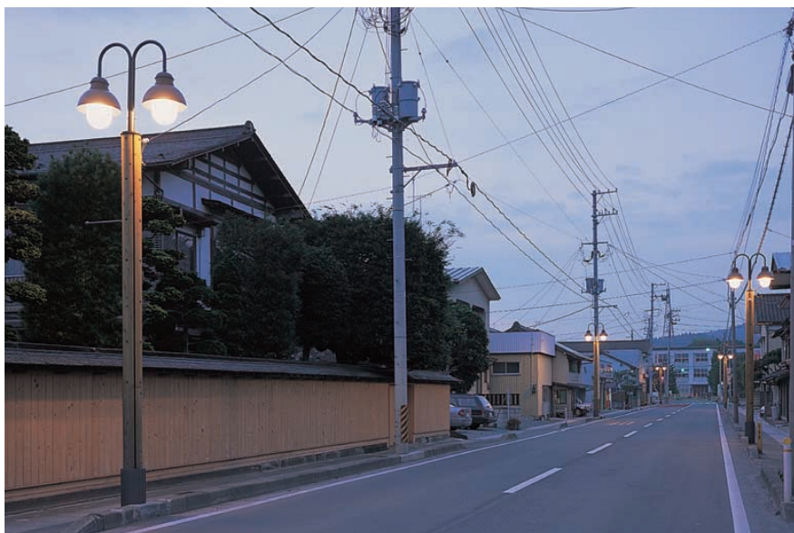
ポールに地元産の杉を4面張りした街路灯が周辺環境と調和をとりながら温かみのある景観照明を実現
