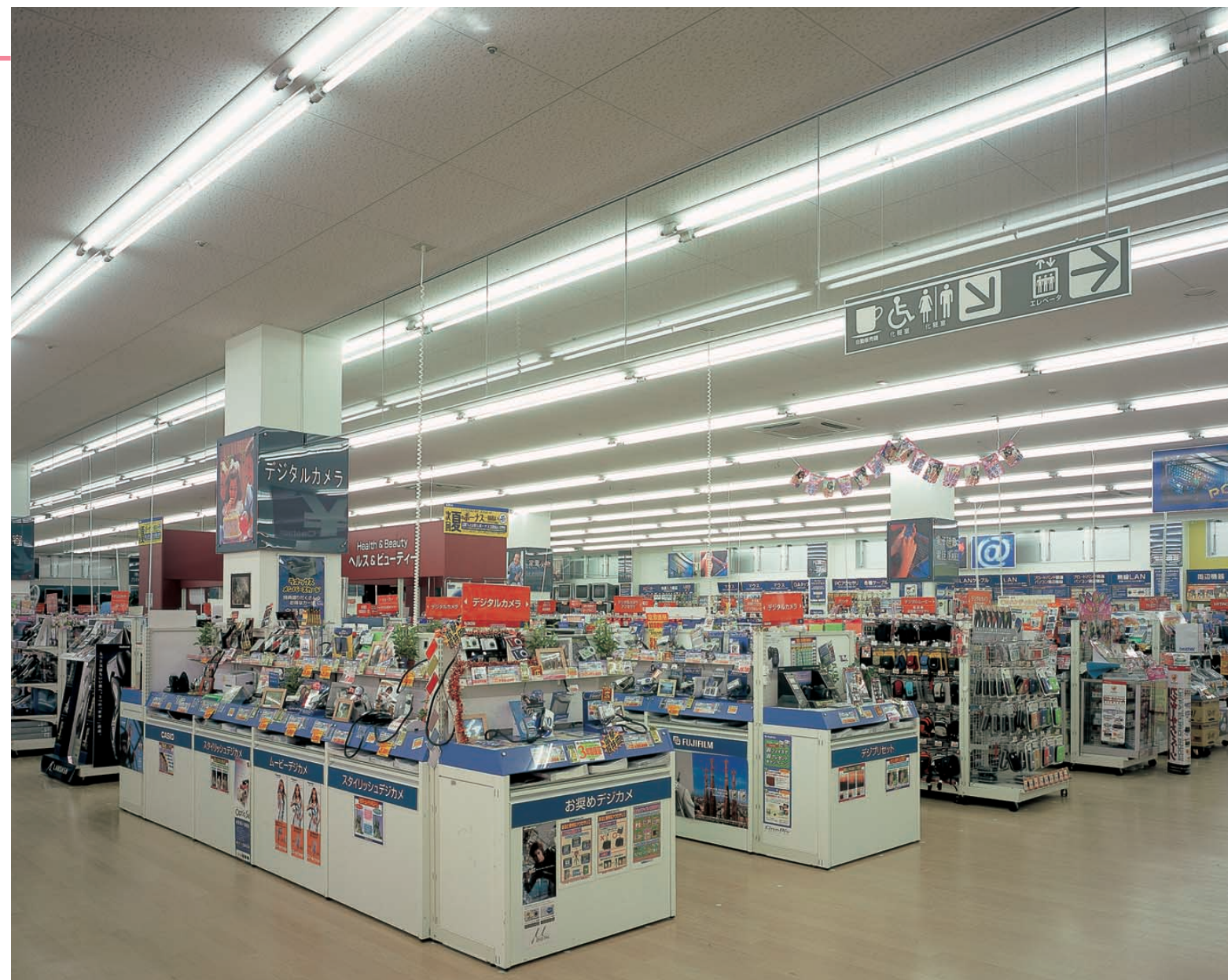
86WHf蛍光ランプ2灯用逆富士形器具をライン状に連結配置し、明るく奥行き感のある商空間を創り出している
