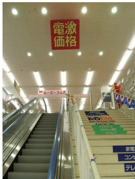
250Wメタルハライドランプダウンライトによるエスカレーター・階段照明
