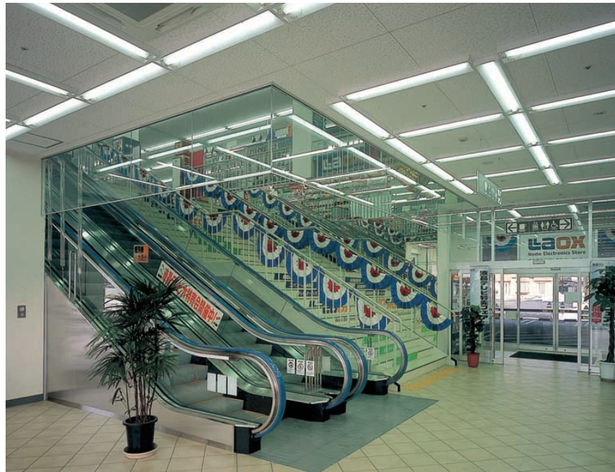
エントランスホールの照明：105WHfコンパクト形蛍光ランプ1灯用直付器具を格子状に配置。より明るい光環境で2階への誘導性を高めている
