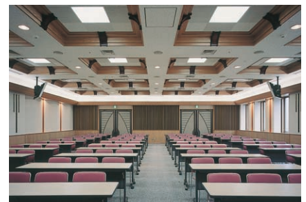
視聴覚室の照明：拡散カバー付の照明器具と間接照明により明るくグレアの少ない照明設備
