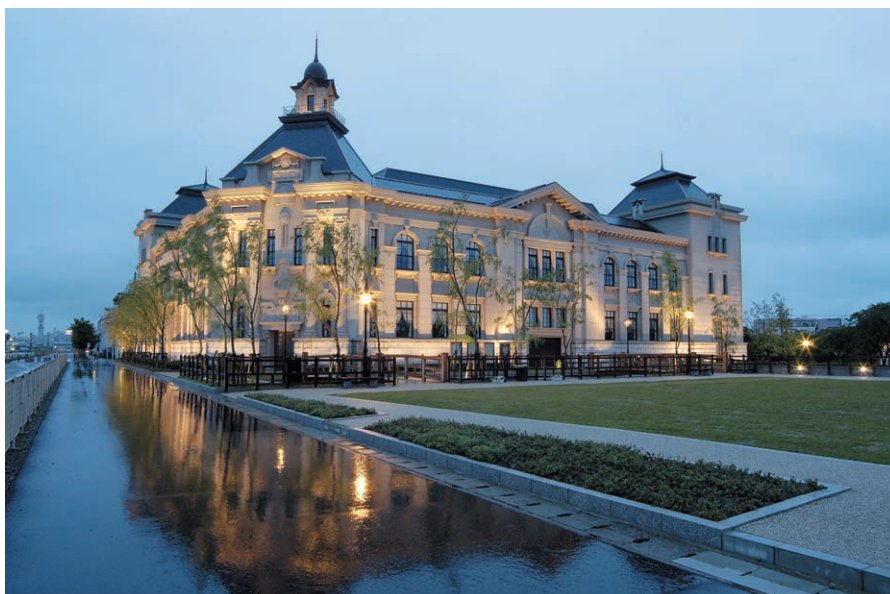
薄暮時の外観：150Wセラミックメタルハライドランプによるライトアップ。雨上がりの道路に映り込み、幻想的な空間を演出
