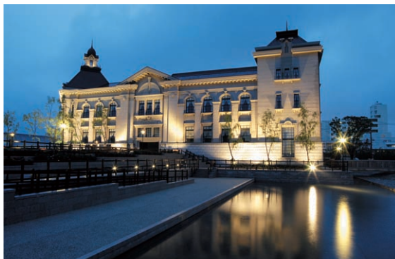
施設のライトアップ及び外構には150W高圧ナトリウムランプの街路灯を、遊歩道には9Wコンパクト形蛍光ランプフットライトを使用
