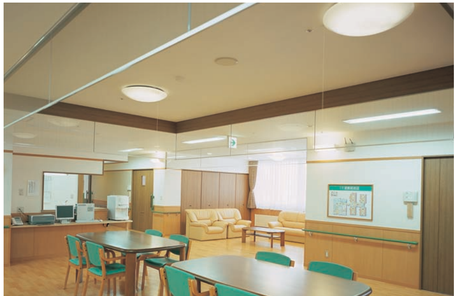
グループケアユニット多目的食堂の照明：76W形環形蛍光灯ランプ“ネオスリムV”シーリングライト2台を設置
