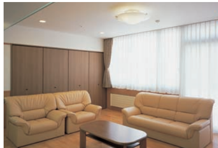
ユニット談話室の照明：電球形蛍光灯ランプのシーリングライトとダウンライトを採用
