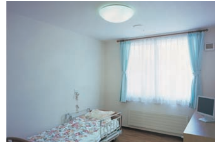
シーリングライト(72W形サークライン)を設置したユニット個室の照明
