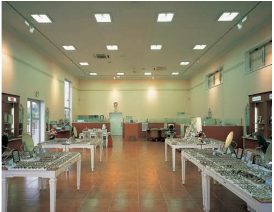
店舗正面入口から奥を望む内観：二重角形蛍光ランプ薄形スクエア直付器具(HfネオスクエアII)を整列配置
