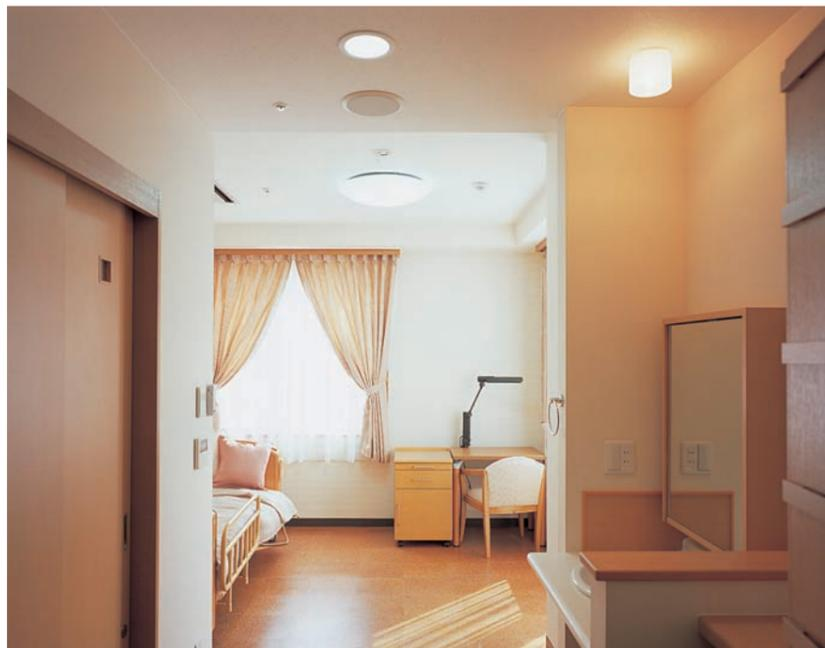
ユニットケア個室の照明：薄形シーリングライト「ネオスリムV」をベース照明に採用し、影の出にくいミラー灯とLEDダウンライトの常夜灯を設置
