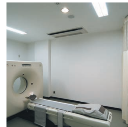
Hf埋込器具と白熱灯ダウンライト(調光可能)を採用したCT検査室
