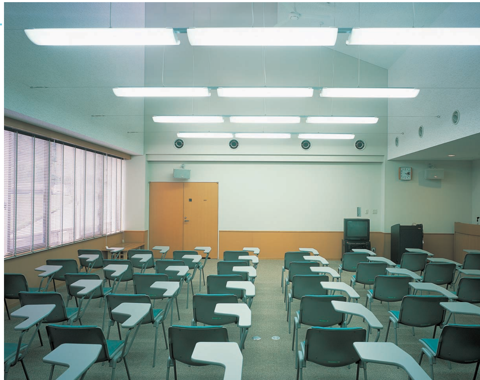
講堂の照明：105WHfコンパクト形蛍光ランプグローブ付ワイヤ吊器具を設置、開放感のあるソフトな照明環境を創出
