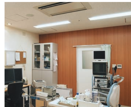
診察室の照明：Hf器具とユニバーサルダウンライトを設置
