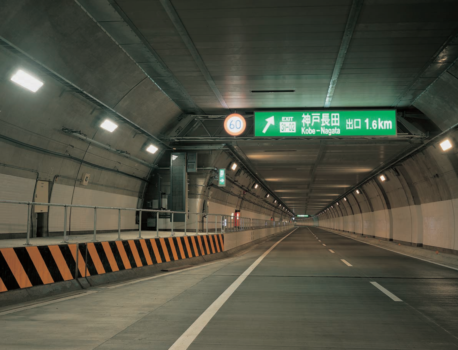
神戸長田トンネル南行線
