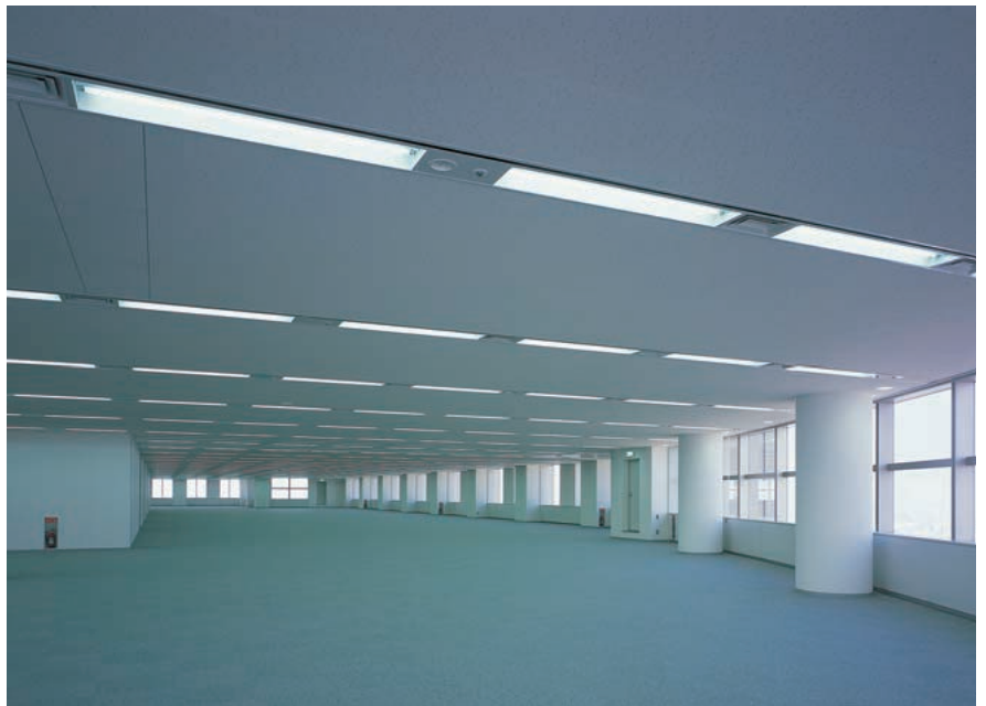
27階オフィスフロアの照明：システム天井の設備ラインに32WHf蛍光ランプ2灯用埋込開放形器具をはじめあかりセンサ、空調アネモ、各種感知器等を配置
